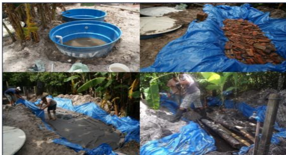
Figura 1, sistema de esgoto em estágio de montagem Fonte: Francisco Xavier, 2012.
