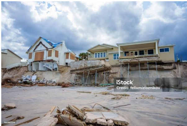
Foto 26 – Imóvel à venda localizado junto a uma encosta
