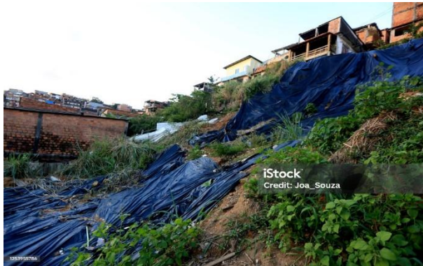
Foto 35 – Desmoronamento em Salvador em consequência de fortes chuvas
