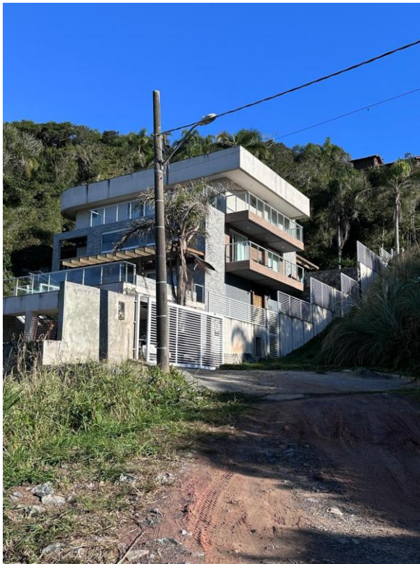
Foto 37 – Construção em área de risco
